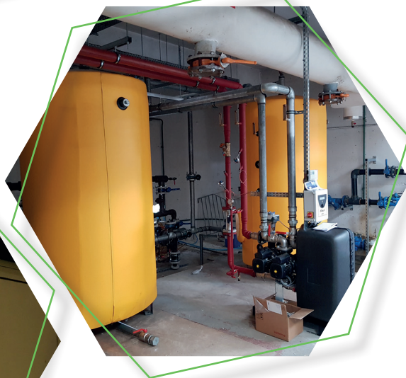
Juin : Installation de l'eau chaude sanitaire pour les groupes 8 et 9 du quartier de Vaux
