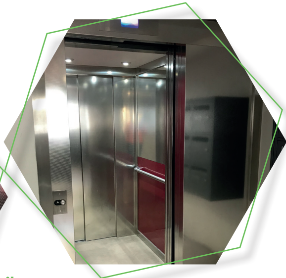
Avril : Installation des ascenseurs au 8ème Groupe du quartier de Vaux
