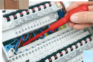
Mise en sécurité des tableaux électriques
