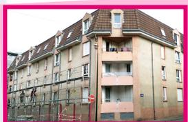
Dans la deuxième partie, la pose de fenêtres et de l'isolant thermique sur les façades a commencé.
